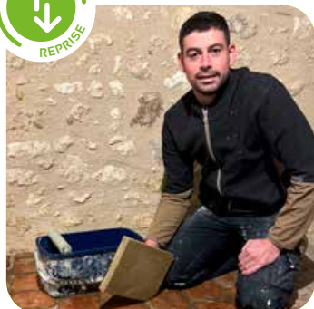
2024, Simon Chebret, maçonnerie, rénovation à Ingrandes
