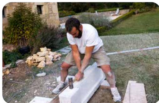
2024, Corentin Garnier, maçonnerie traditionnelle, rénovation, taille de pierres, ravalements de façades à Azay-le-Ferron.
